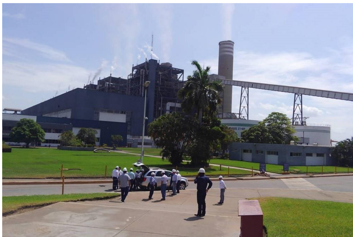
メキシコ電力公社（CFE）ペタカルコ発電所（ゲレロ州）
